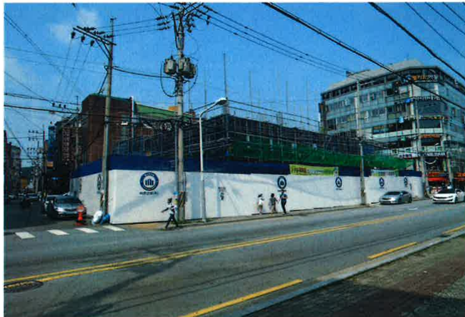
본건 전경(남서측에서 촬영)
